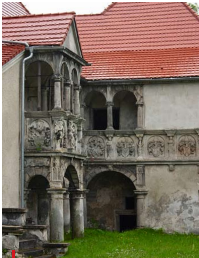
Uratowanie barokowych krużganków, przylegających do odremontowanego kościoła filialnego, to największe wyzwanie parafii
