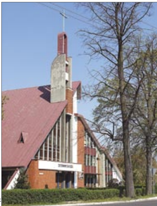
Kościół w Porajowie zadziwia architekturą, choć ma już przeszło 30 lat
